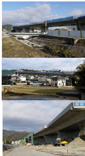
←12日現在の「にそと」工事の様子
