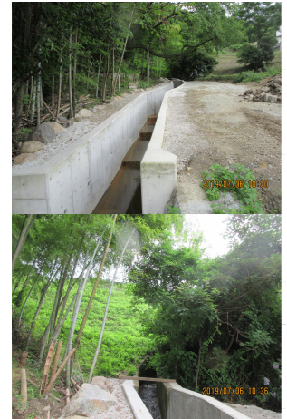
完成した排水路
