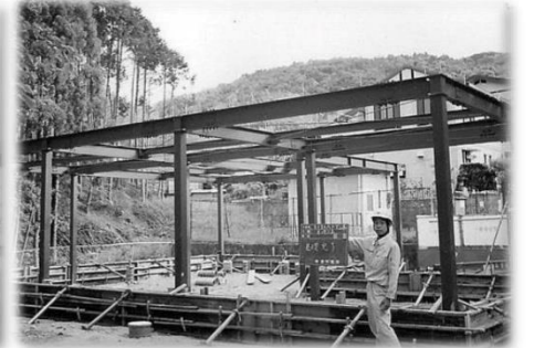
工事中のさくら会館
